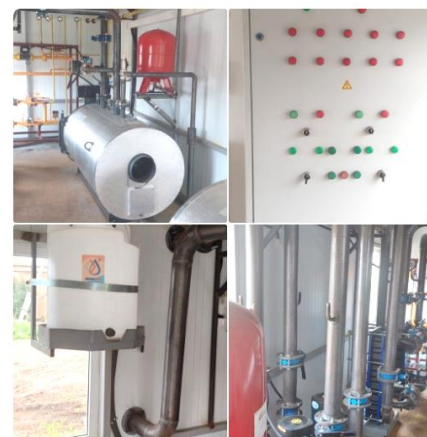
Модернизация котельной в д.Сметанино (установка блочно- модульной газовой котельной)
