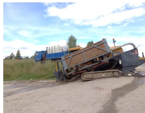
Строительство газопровода в дер.Наумиха и мкр.Черемушки
