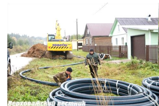
По проекту «Народный бюджет» ремонт водопроводных сетей в д.Леушинская
