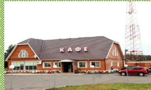
ИП Чистяков А.Ю. «Строительство придорожного сервиса»
