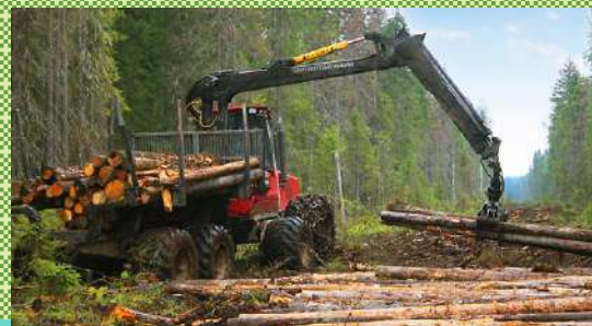
ЗАО «Вожега - лес» «Строительство лесных дорог»
